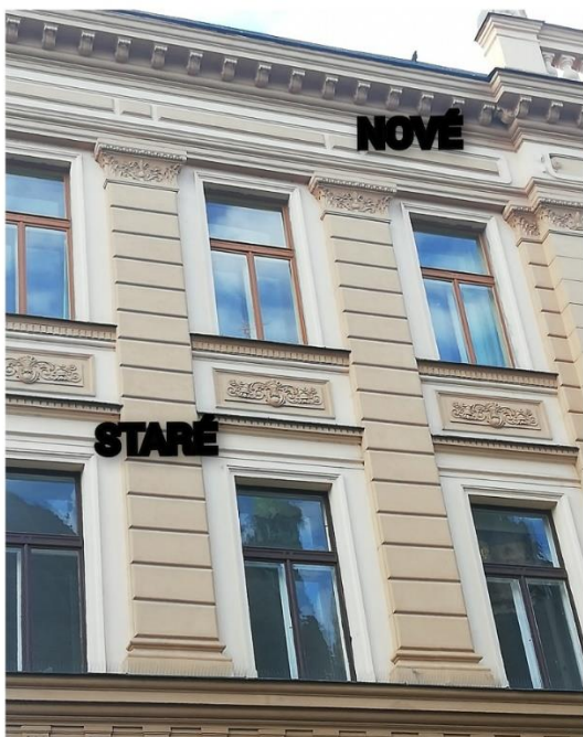
Obr. č. 2 – Rekonstrukce a výměna oken a dveří
