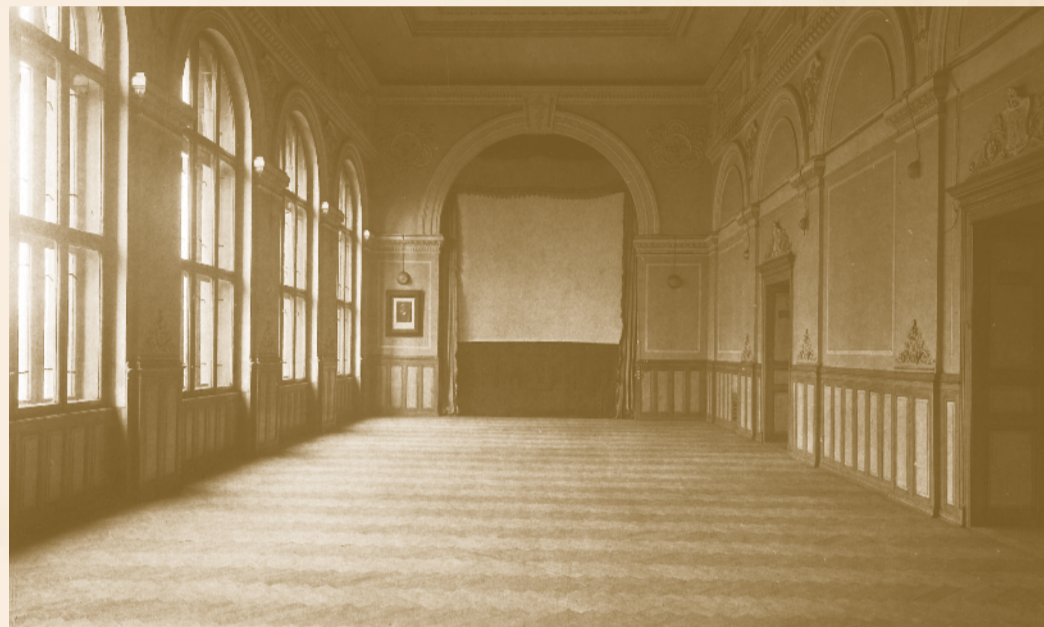
Aula školy, která původně sloužila jako kaple
